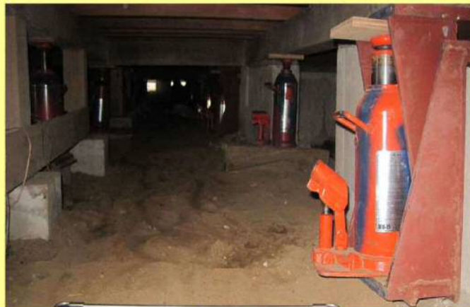
ガンギジャッキセット状況
