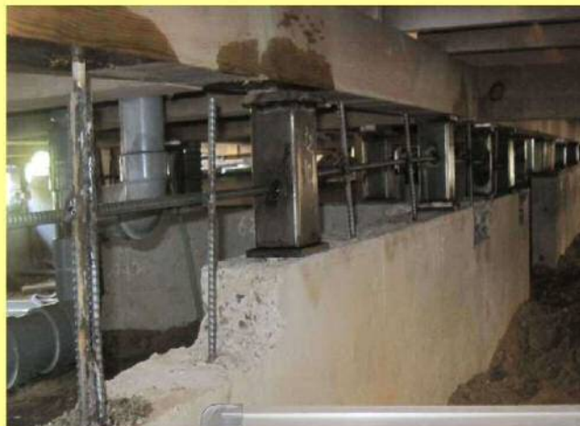
アンカー設置、配筋溶接
