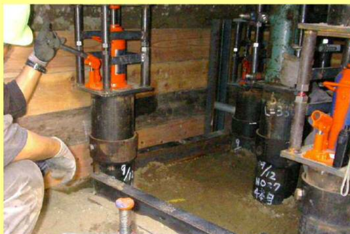
鋼管圧入状況
