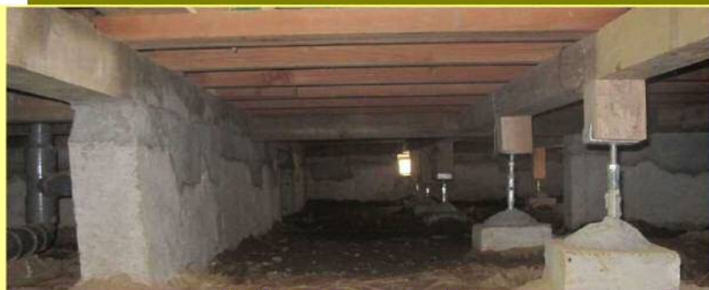
補強コンクリート充填
