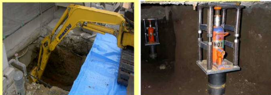
基礎下掘削完了状況
