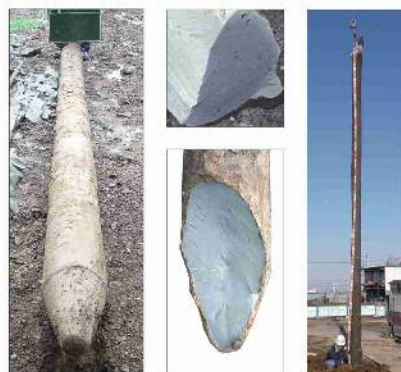
掘り起こしたピュアパイル
