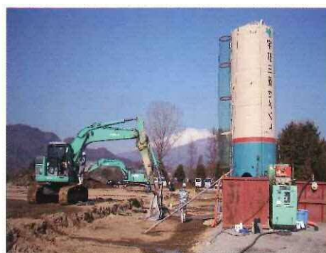
施工状況全景
