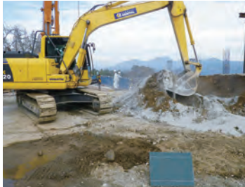
日本平ホテル 本体表層地盤改良
