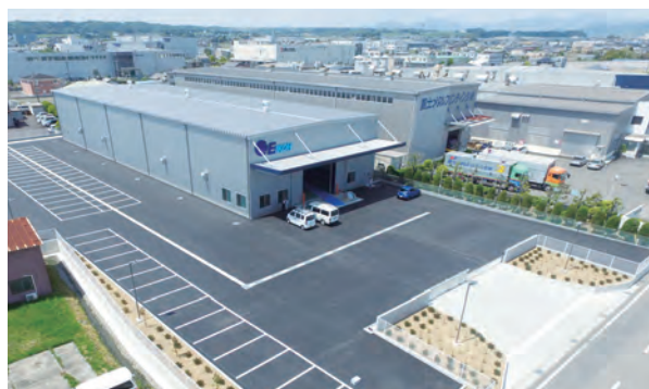
倉庫建設工事
